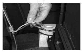
Connect the fan wires.
